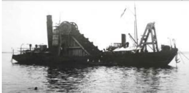
Землечерпальниця виконує днопоглиблення в акваторії МТП.
