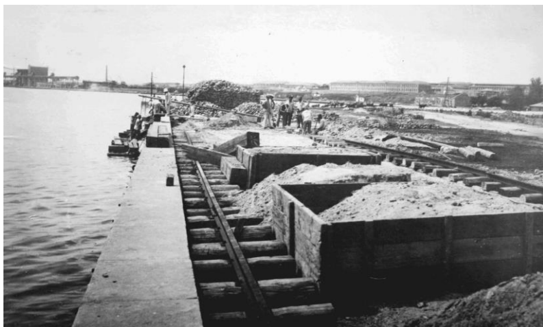
Покладання рейкових колій для зерноперевантажувачів і встановлення охоронної рами причалів. 1925 р.
