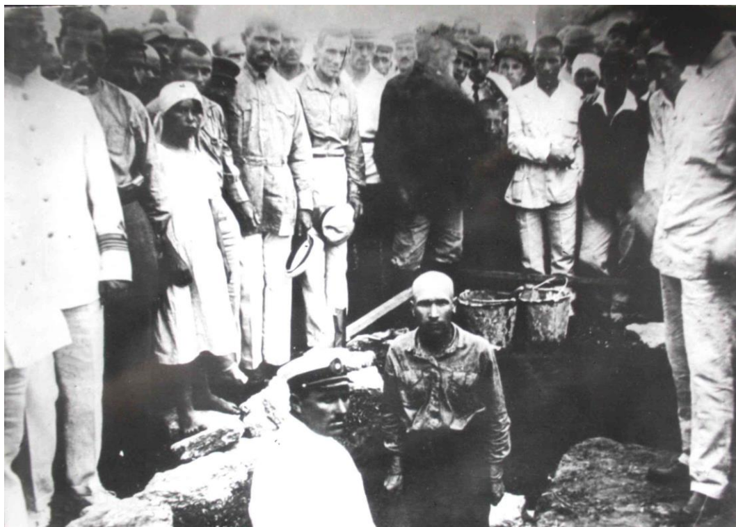
Нач. порту А.А. Гончаров (на передньому плані) закладає пам'ятну дошку у фундамент першого житлового будинку. 1925 р.
