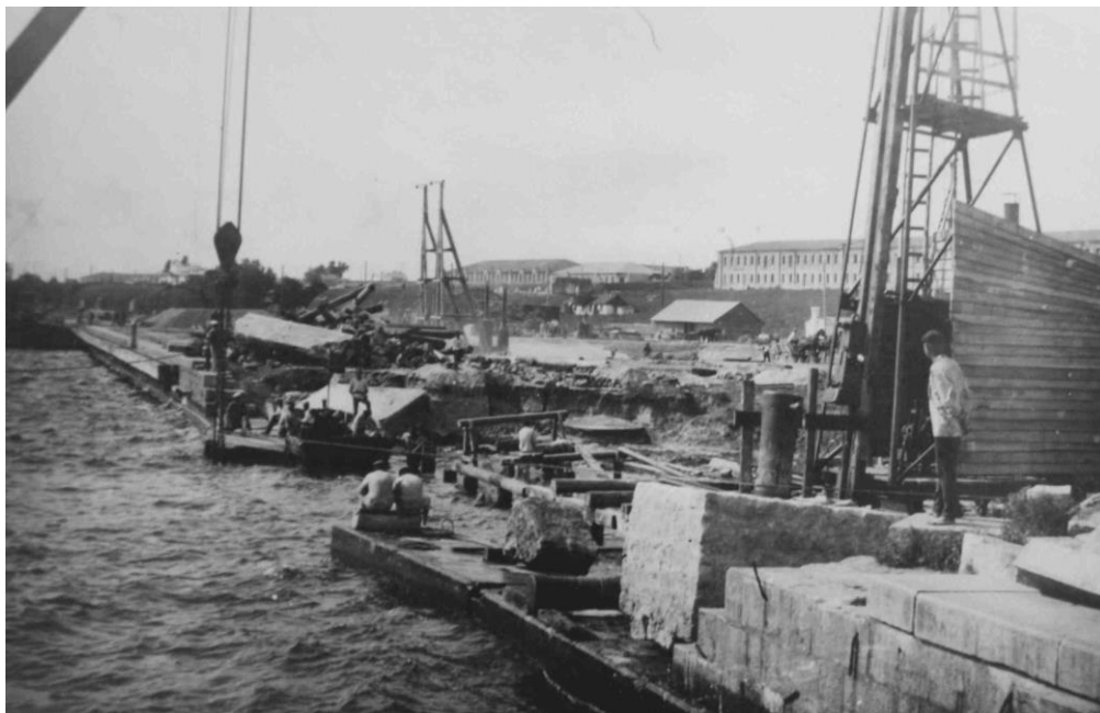
Ремонт причалів, забивання паль.
