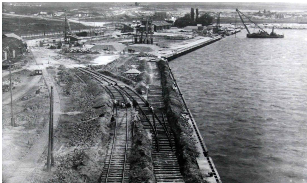
Виправлення набережної перед будівництвом нового стаціонарного елеватору, переукладання залізничних колій, 1925 р.
