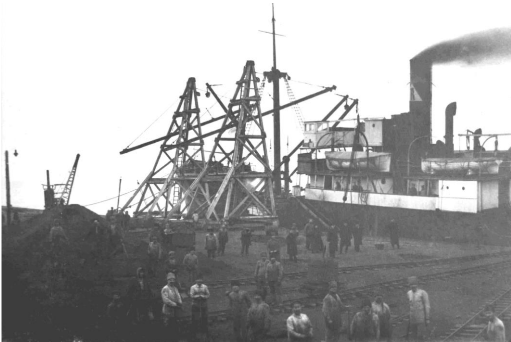
Навантаження руди підвісними «стрілами Темперлея», 1925 р.
