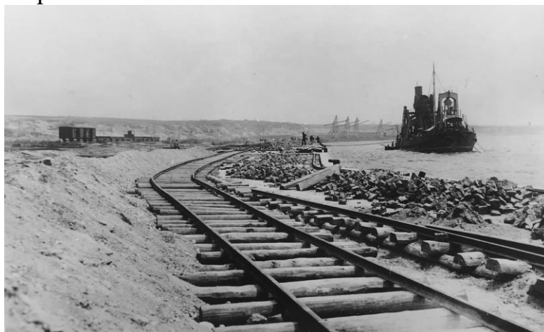
Ремонт причалів, поглиблення акваторії. 1924 р.
